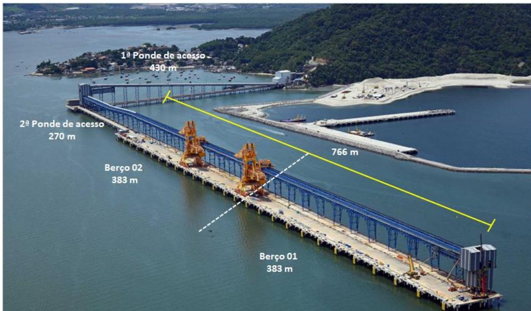
O Píer possui comprimento total de 766 metros, dividido em 02 (dois) berços de atracação, equipados com 27 defensas (Sumitomo) com espaçamento de 28,8 metros uma da outra.
